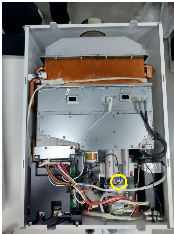
Imagem 18 - Ponto para medição da pressão dinâmica 32 e 36 litros.
