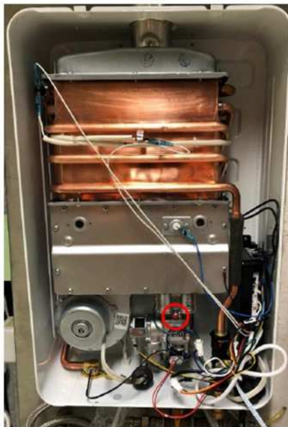
Pontos de medição de pressão de gás com manômetro
