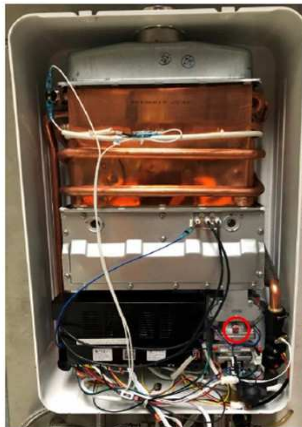
Pontos de medição de pressão de gás com manômetro
