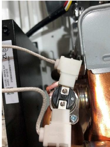
Imagem 13 - Limitador de temperatura (ativação 75°C)
