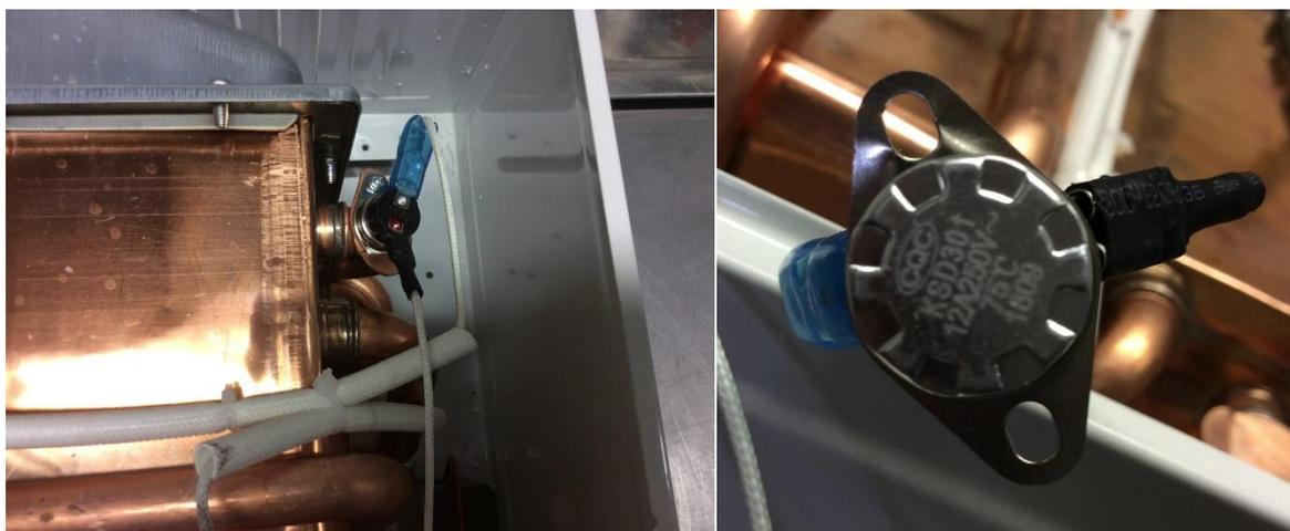
Imagem 12 - Limitador de temperatura (ativação 75°C)
