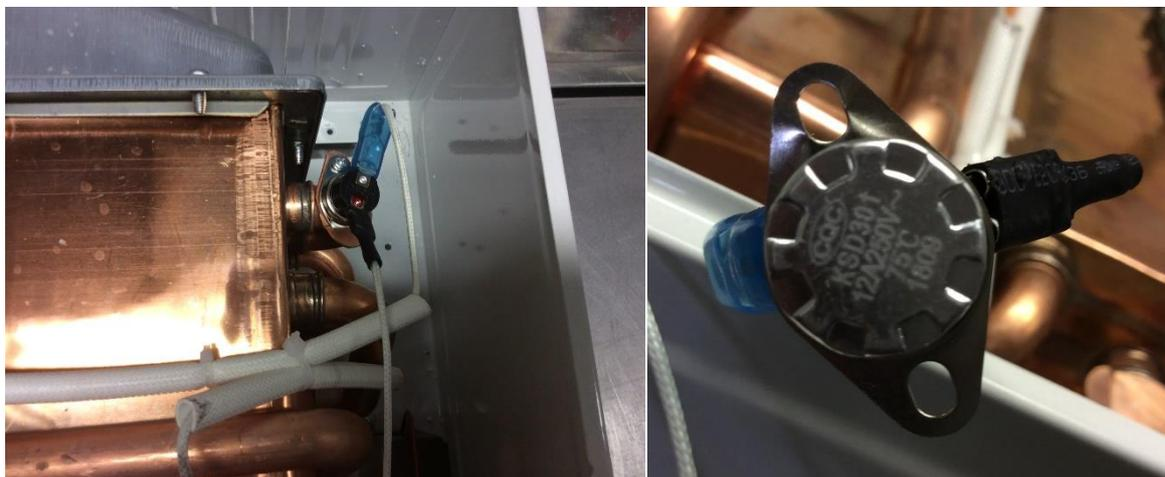
Imagem 11 - Limitador de temperatura (ativação 75°C)
