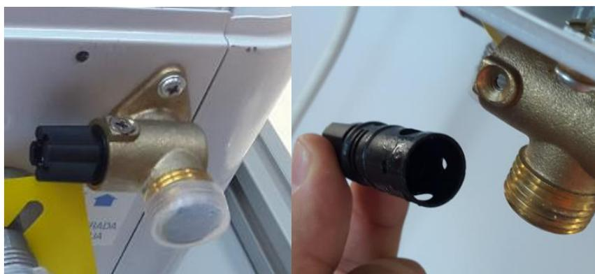
Imagem 2 – Entrada de água fria – regulador de vazão
