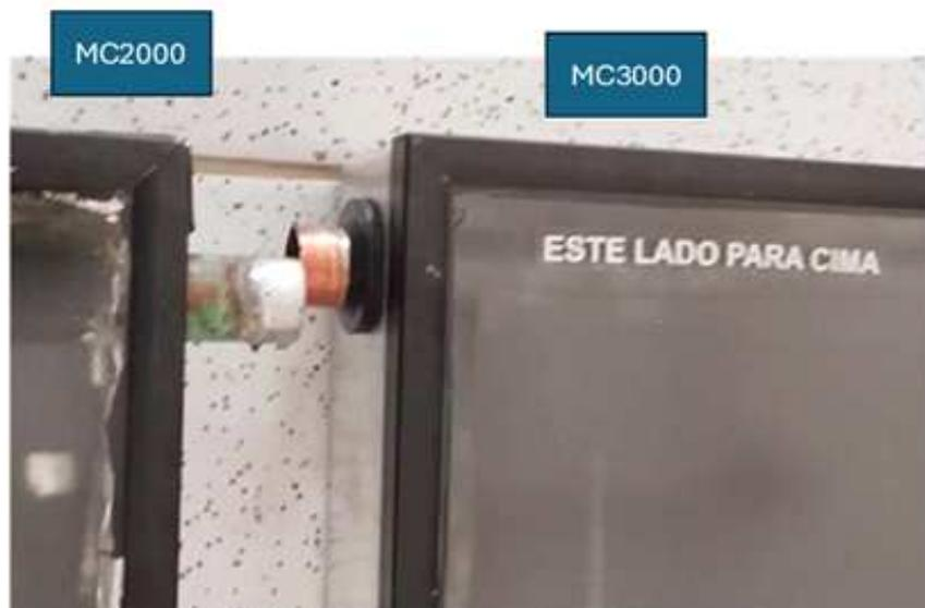
Para que seja possível instalar os diferentes modelos de coletores em uma mesma bateria, é necessário realizar algumas adequações.
