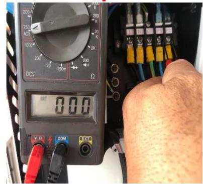
Quando a temperatura da água de entrada atinge ou é superior a temperatura de setpoint, a bomba de calor desliga a moto bomba cortando a tensão de 220VAC para os terminais P1/P2.
