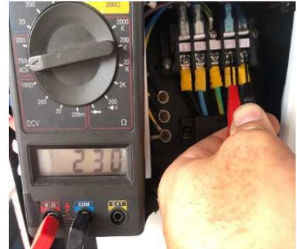
Quando a temperatura da água de entrada é menor que a temperatura de setpoint, a bomba de calor libera uma tensão de 220VAC através dos terminais P1/P2, que deverá alimentar um comando externo para acionar a moto bomba.
