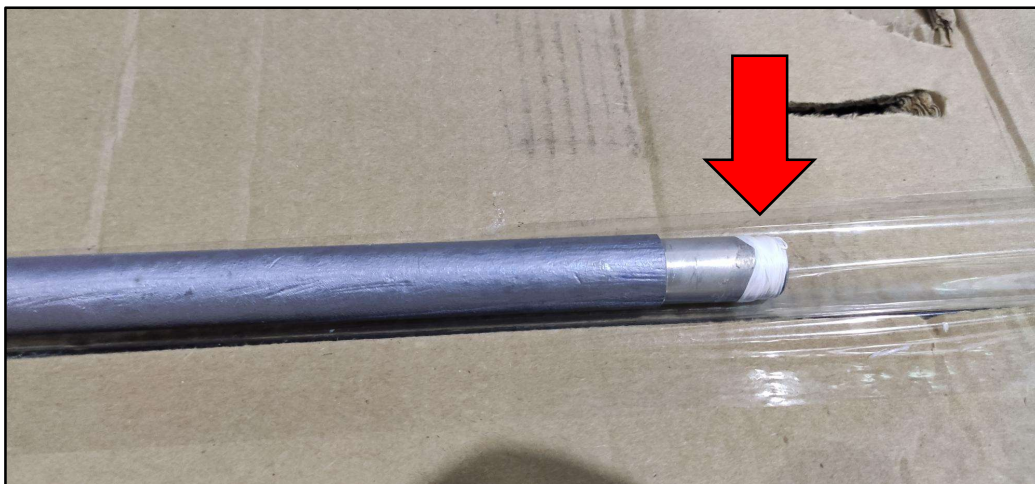
Figura 7 - Aplicação fita veda rosca
